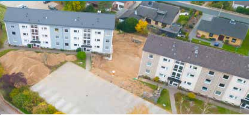
Wohnanlagen am Wasserkrüger Weg 169 bis 187 in Mölln.
